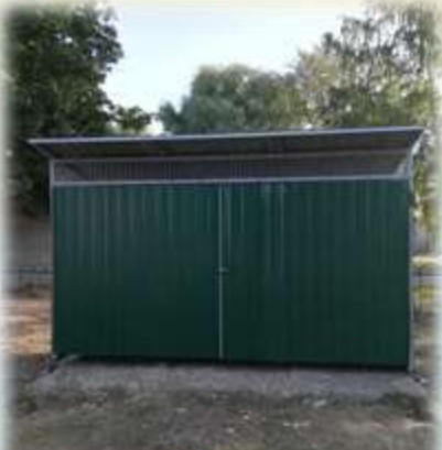
Ремонт площадки сбора ТКО
